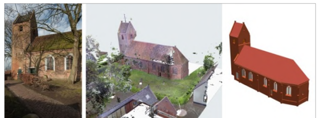
Kerk in Obergum, Groningen: BIM op basis van een Point Cloud Scan
